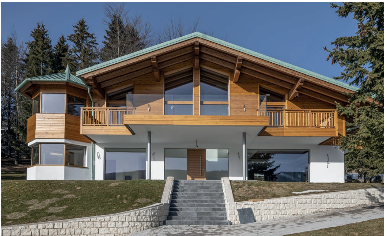
Villa privata – Rooftop, terrasses et espaces extérieurs Folgaria (TN), Italia Pedestal System – Eterno SE e Star.T
