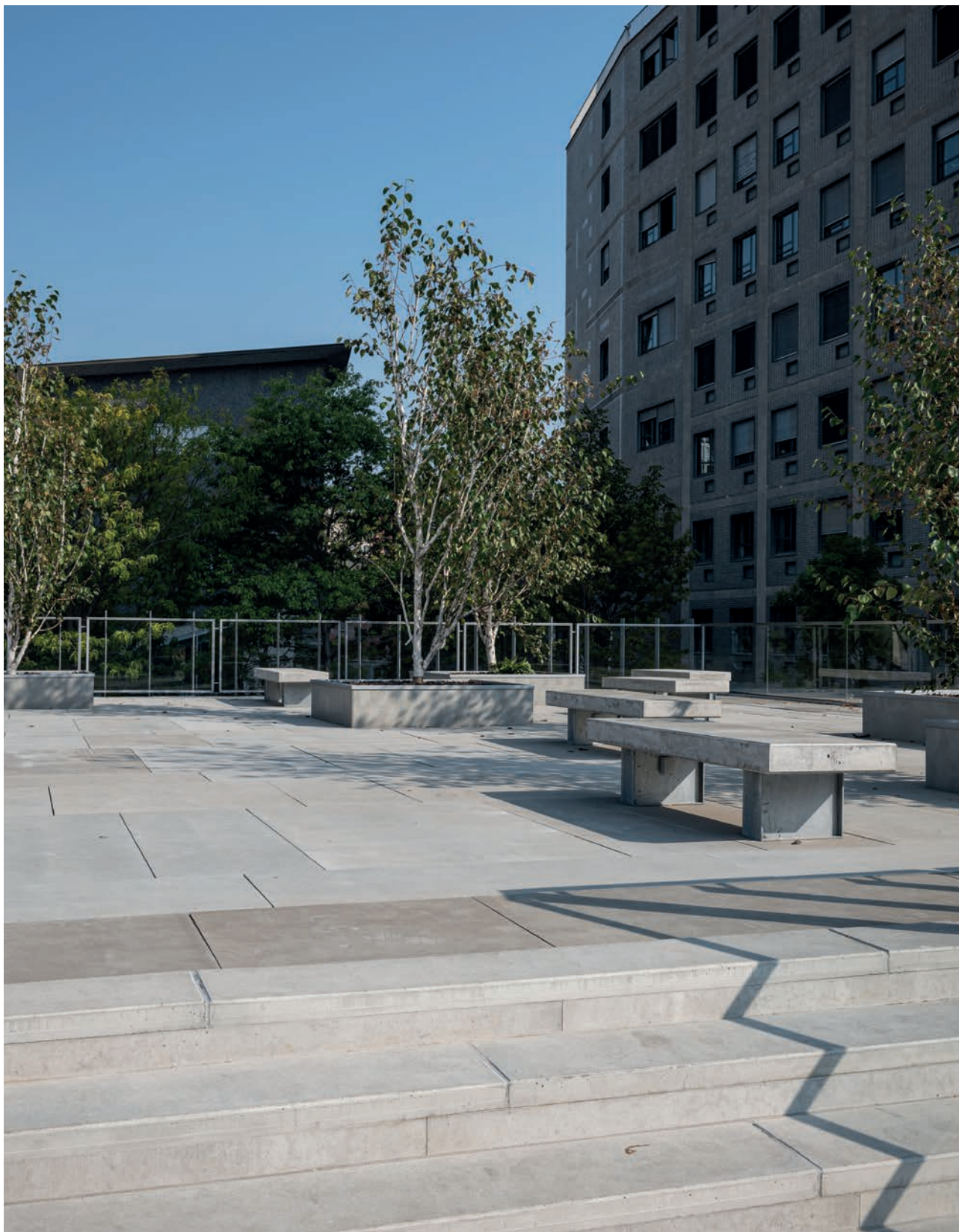
Politecnico di Milano – Passaggi pedonali e camminamenti Milano, Italia Woodeck System – New Maxi NM
